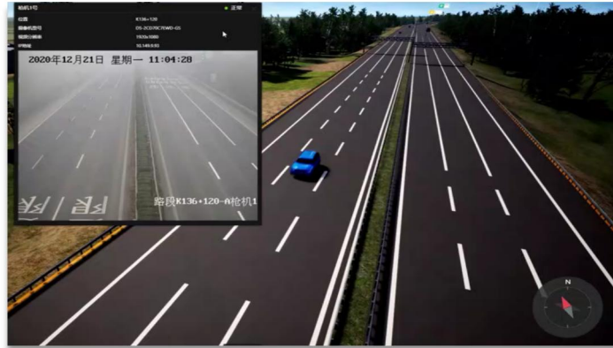
图 4-40 一体化运行监测平台“全息瞳”系统
